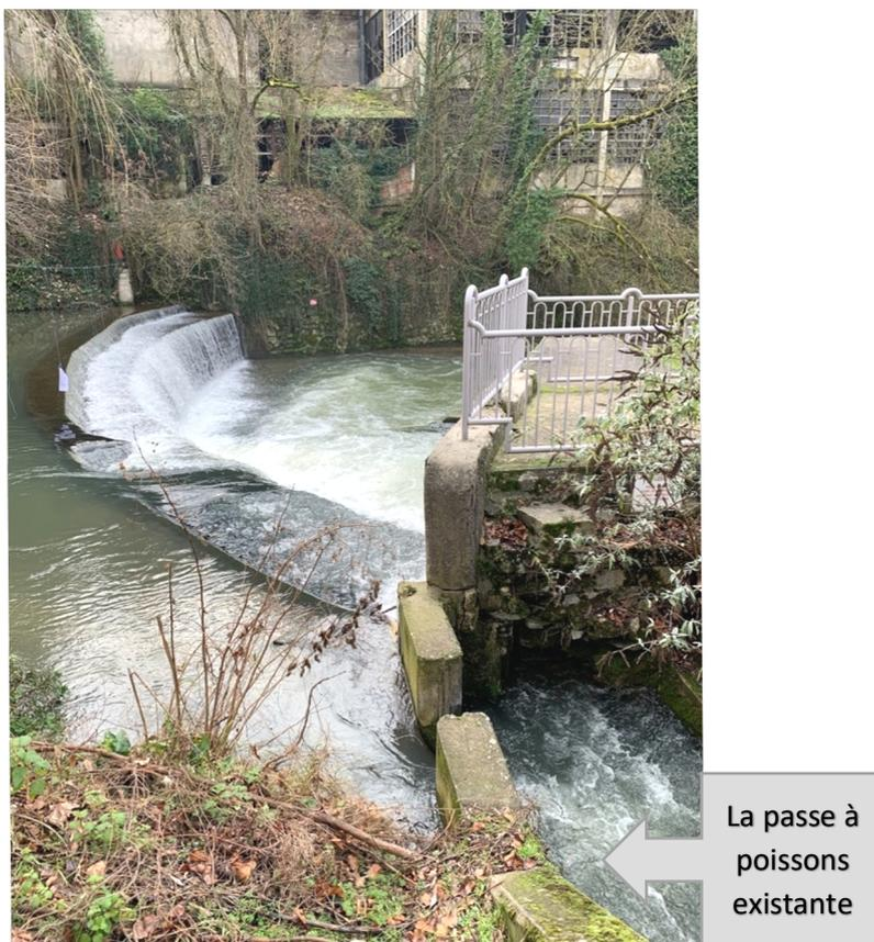
Ancienne prise d'eau industrielle, le seuil constitué de pierres maçonnées disposées en arc de cercle dispose en rive droite d'une passe à poissons.
