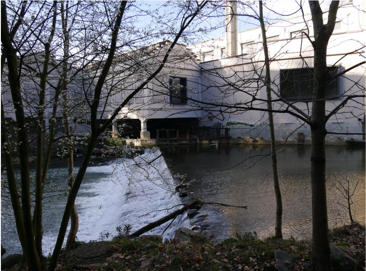
Seuil vertical constitué de pierres maçonnées, raccordé à la rive droite par une chambre d'eau faisant partie intégrante du bâtiment industriel qui abrite aujourd'hui le musée de la Draperie.
