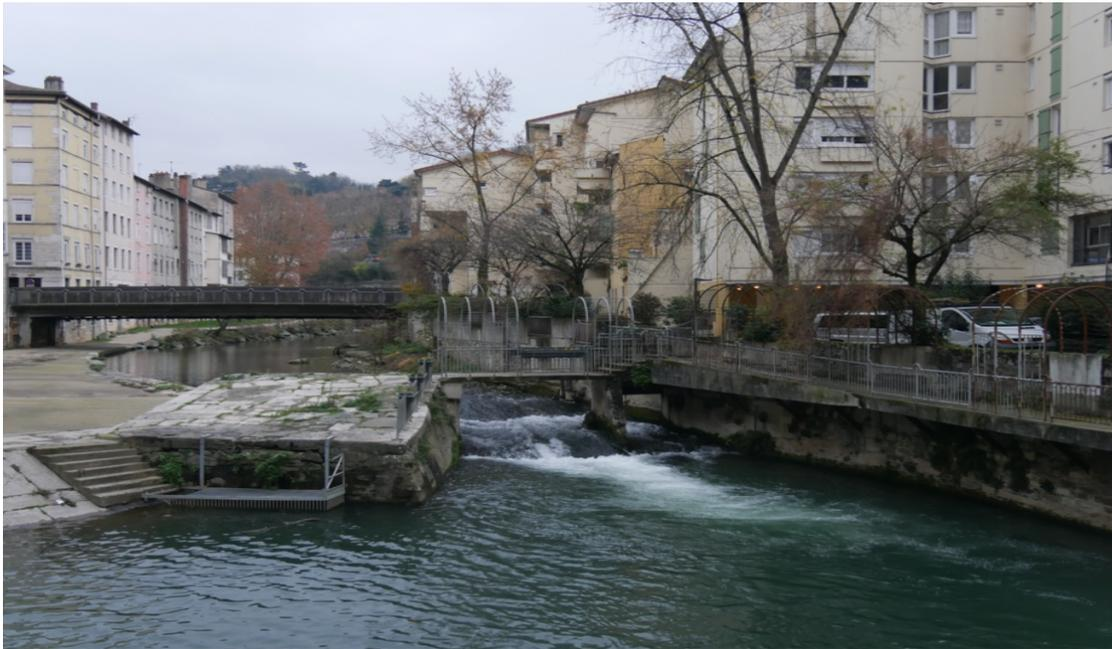
Le seuil est structuré autour d'un quai en rive droite et deux pertuis, en rive gauche, séparés par une pile centrale.
