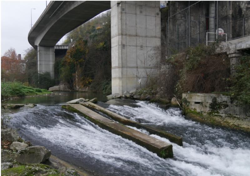
Il s'agit d'un barrage à déversement oblique constitué d'une maçonnerie de pierre de taille de dimension métrique, recouverte de béton avec au centre une passe à canoé. En rive gauche, l'ouvrage se raccorde à la rive au niveau de la pile du Pont de la Déviation.
